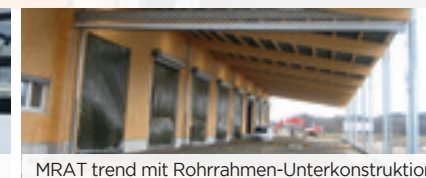
MRAT trend mit Rohrrahmen-Unterkonstruktion
