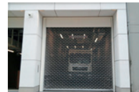
MRAT trend mit Unterkonstruktion und Blechverkleidung
