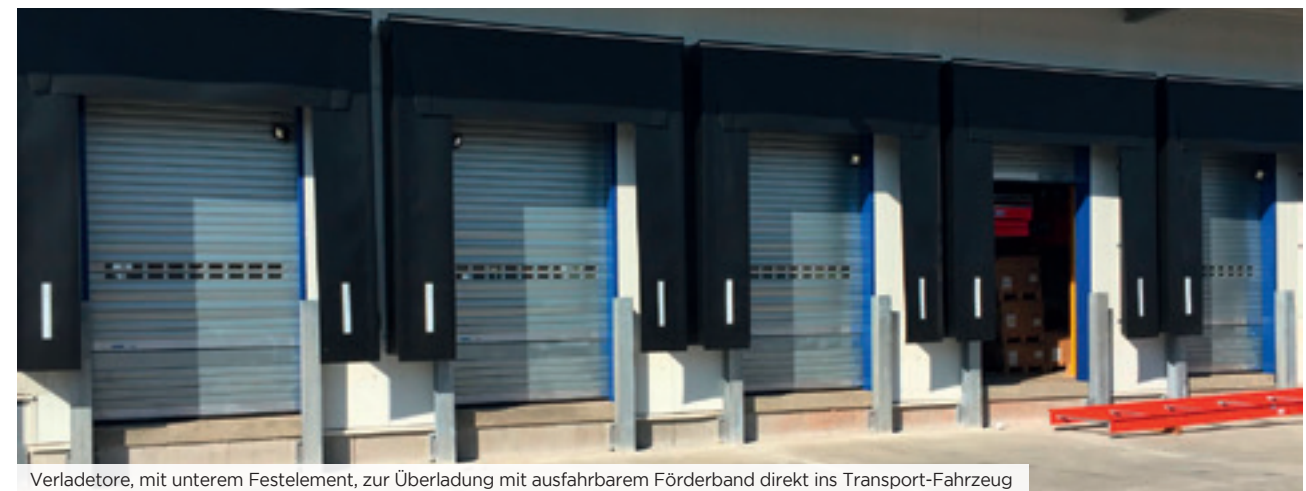
Verladetore, mit unterem Festelement, zur Überladung mit ausfahrbarem Förderband direkt ins Transport-Fahrzeug
