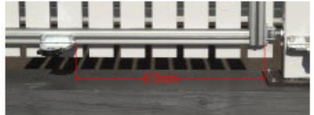
Um den Torbeschlag am Pfosten zu montieren, müssen Löcher mit  $\text{Ø}6,5\text{mm}$  gebohrt werden. Die beigelegten Spezialschrauben können ohne Gewindeschneiden eingedreht werden. Wichtig ist, dass die beiden Beschläge (Tor und Pfosten) in der Waage sind. Ansonsten funktioniert der Antrieb nicht richtig.
