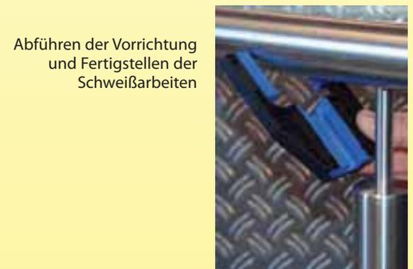
Abführen der Vorrichtung und Fertigstellen der Schweißarbeiten
