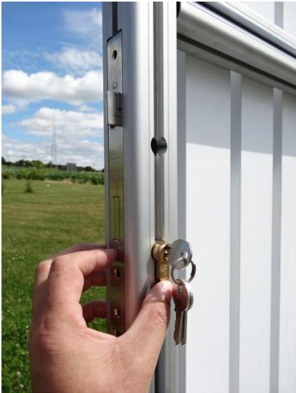
Zylinder 50/30 in vorgefertigtes Profil einstecken.
