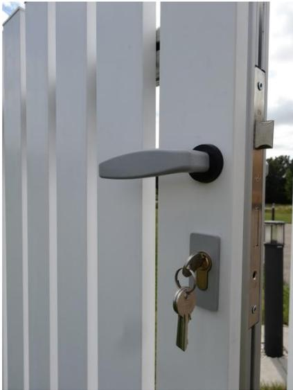
Torbelag anbringen, bei bauseitigem Torbelag müssen die Zylinder- und Drückerausparung selbst gebohrt werden.
