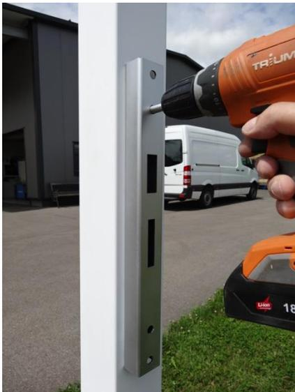
Schließblech am Pfosten positionieren und mit 4x Senkkopfschneidschraube M4 x 25 befestigen.
