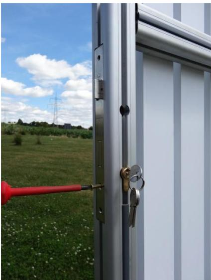
Zylinder mit Befestigungsschraube festschrauben.
