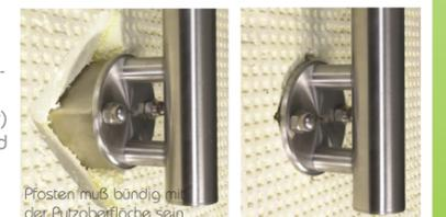
Pfosten muß bündig mit der Putzoberfläche sein.
