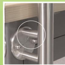
Der Handlauf und auch die Füllstäbe müssen immer so zugeschnitten werden, dass die Enden über die Pfosten hinaus, bis zum Gelenk für den Handlauf oder zu dem Biegegelenk für die Füllstäbe, reichen. Aus diesem Grund sind das Handlaufrohr und die Füllstäbe mit einer Überlänge (1,50m) im Karton vorhanden. Die Pfosten dürfen jedoch nach der Montage, einen Abstand von maximal 1,20m, aufweisen.
